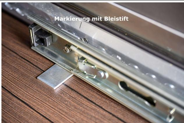
Damit du beim Montieren der Teleskopschiene weißt wo sich die Airlinemutter befindet, empfehle ich die Position mit einem Bleistift zu markieren.
