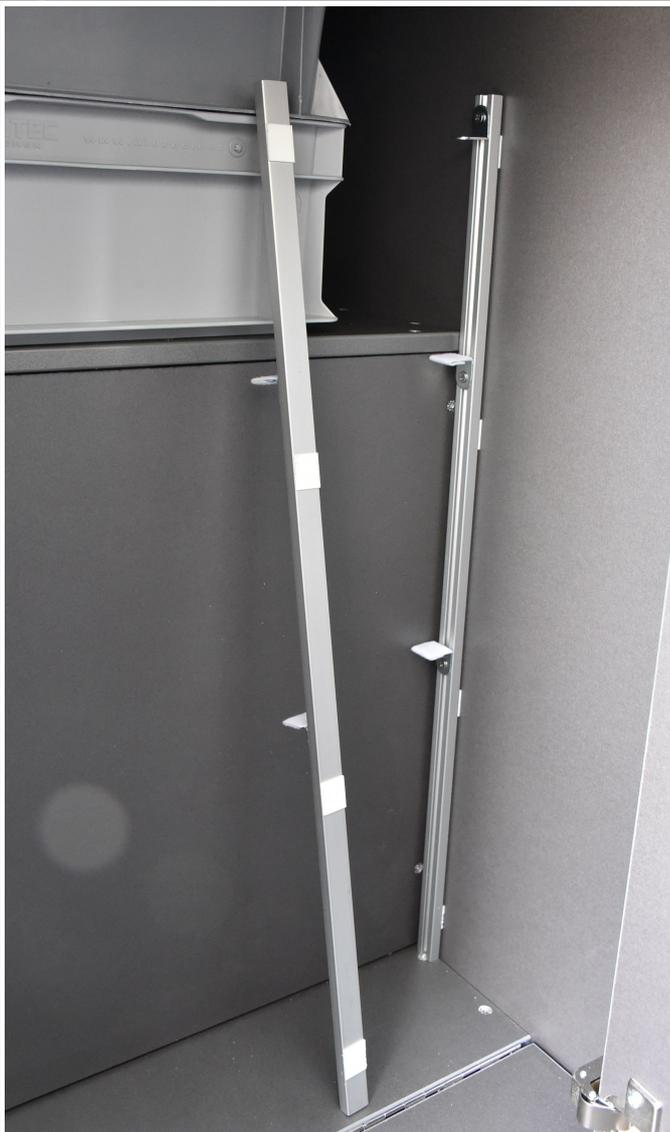
Vor dem Ankleben der Seitenhalter die genaue Position mit Bleistift kennzeichnen. Wenn die Seitenhalter kleben, lassen sie sich nicht mehr korrigieren.
