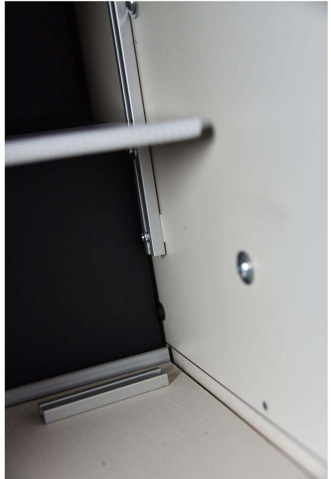
Durch leichtes Anwinkeln kleben die Stirnseiten der Klebeflächen schon etwas fest. Nur in dieser Position kann man noch korrigieren.
